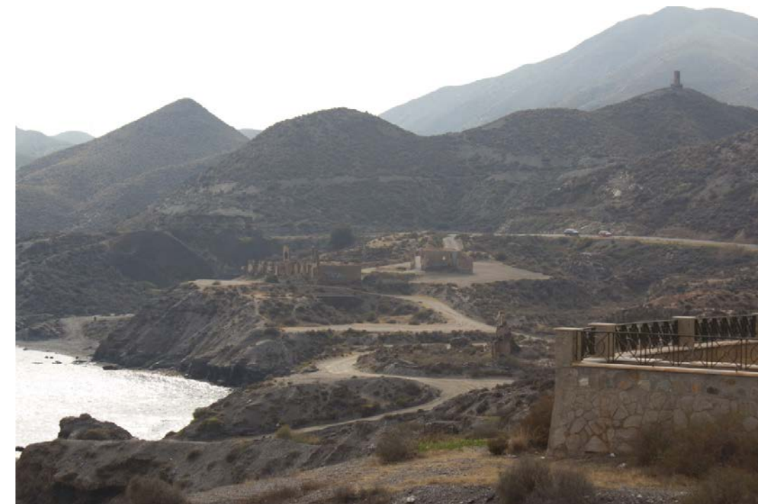
Foto 404: Instalaciones mineras en ruinas en Sierra Almagrera, cerca de Villaricos. Autor: Ricardo Aussó Burguete.
