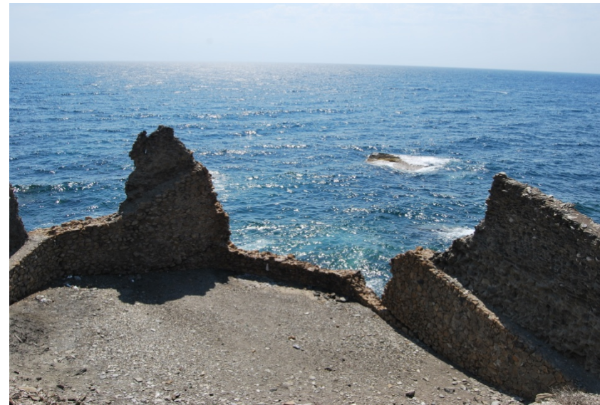
Foto 400: Restos del puente metálico por el que se cargaba el mineral en el complejo minero de la Cala de las Conchas (Villaricos), construido por la Compañía Argentífera de Almagrera en el siglo XIX. Autor: José A. Olmedo Cobo.
