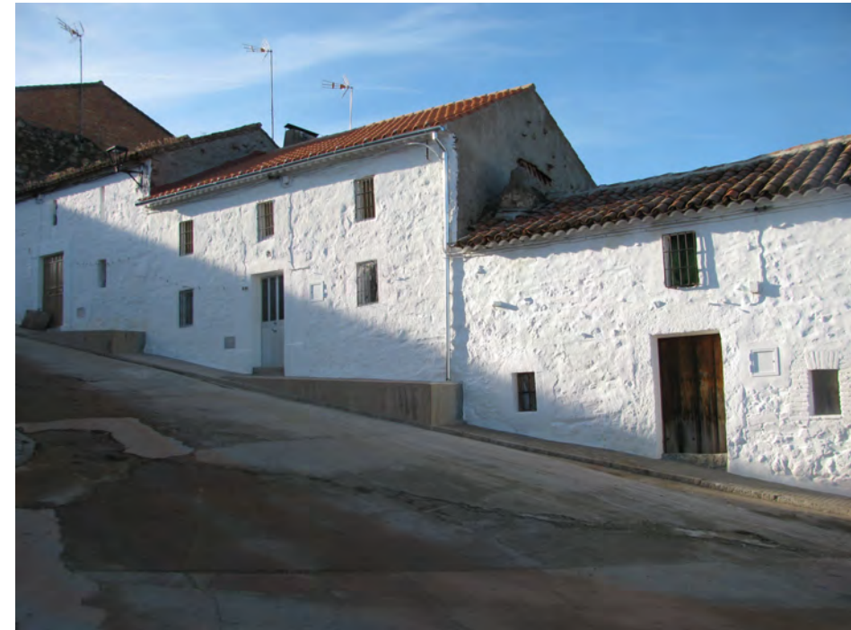
Foto 20: La arquitectura popular en Los Pedroches, un patrimonio de gran expresividad y valores volumétricos. Azuel, Córdoba.
